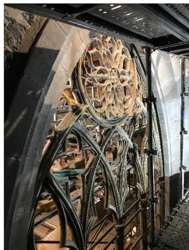
**Une partie des échafaudages a été déposée, et en ce printemps 2024, un travail conséquent va être réalisé sur les colonnes qui soutiennent le grand vitrail. Celles-ci ont été conçues en terre cuite, elles forment le « remplage » de la structure de cet élément majestueux : 7 mètres de hauteur et 3 mètres de largeur.**
