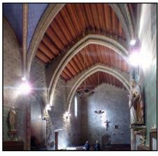
En 1897, une fausse voûte d'ogives a été élevée sur la charpente d'origine. En 1973, la fausse voûte s'écroula et il fut décidé de revenir au parti de la charpente apparente. Malheureusement, les éléments de la charpente apparente d'origine furent brûlés et seuls cinq corbeaux sculptés et peints furent sauvés du feu.
